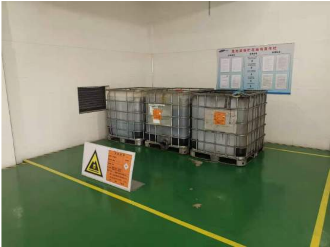
危废标识+危废管理制度+分类存放+环氧地坪
