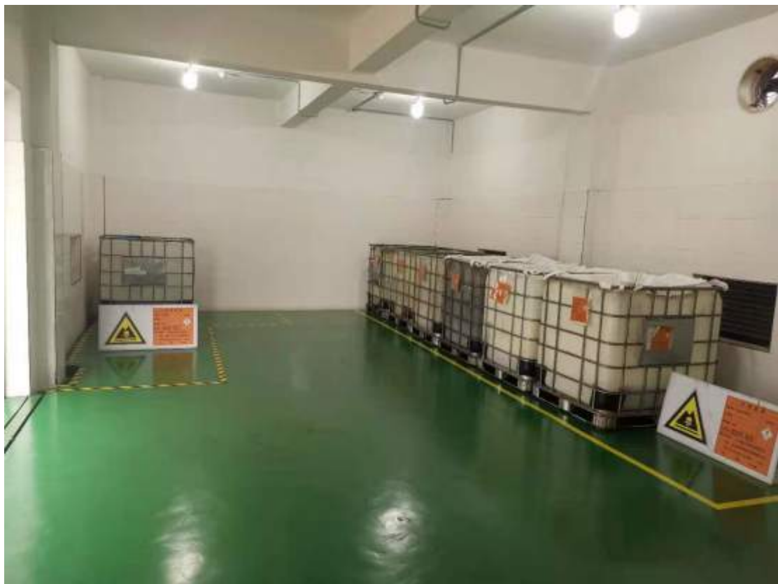
危废标识+分类存放+环氧地坪+通风设施
