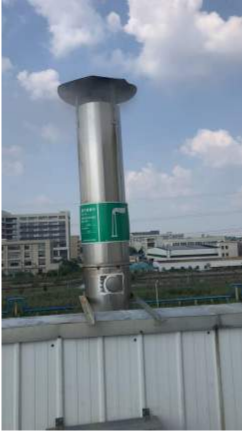
北侧碱雾废气排气筒及水喷淋处理设施
