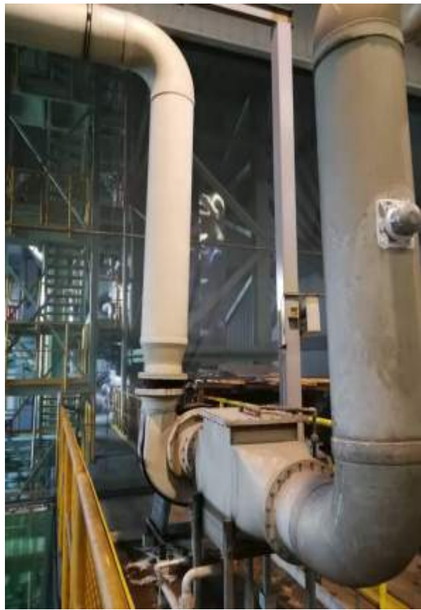
北侧碱雾废气排气筒及水喷淋处理设施
