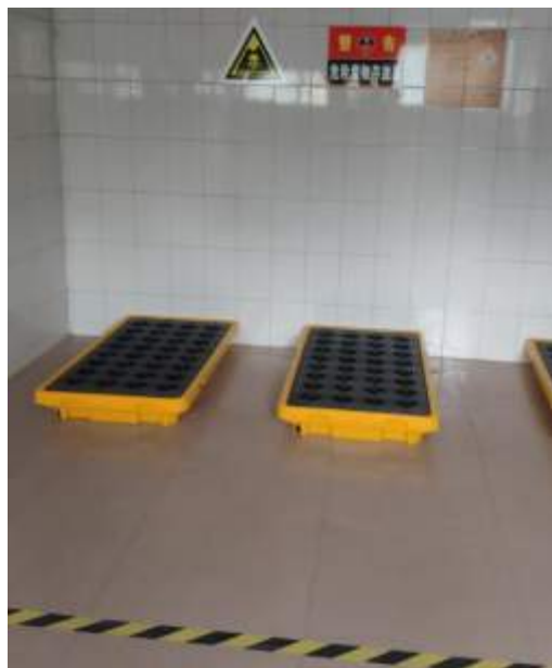
分类存放+危废标识+防渗漏托盘
