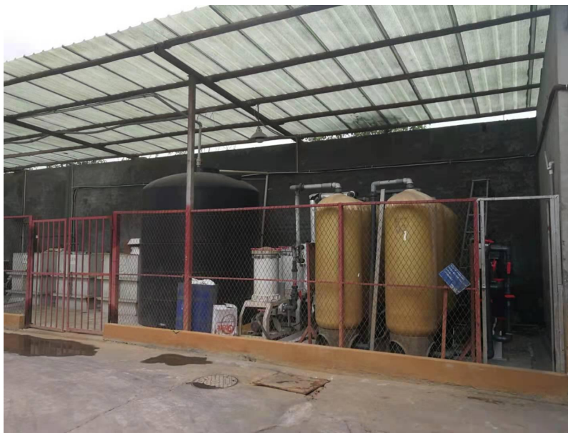
车间处理设施出口
