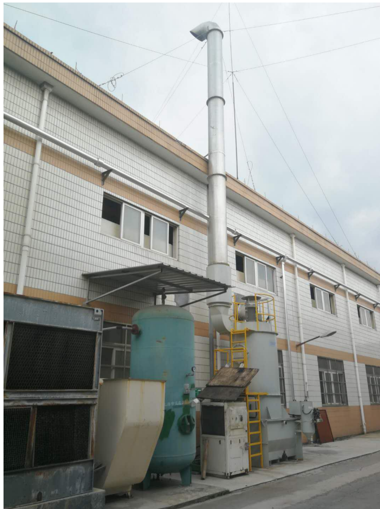
湿式分离器处理装置+15m 高排气筒
