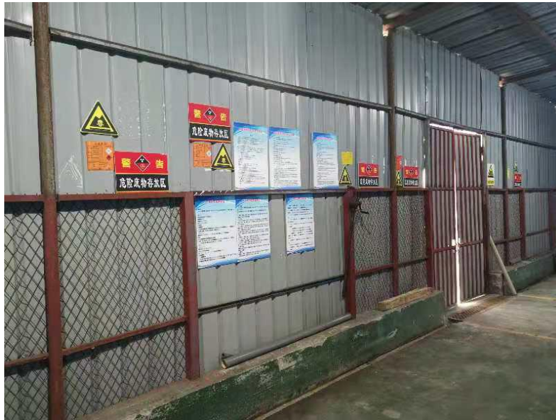
危废标识+危废管理制度+环氧地坪+导流沟+分类存放
