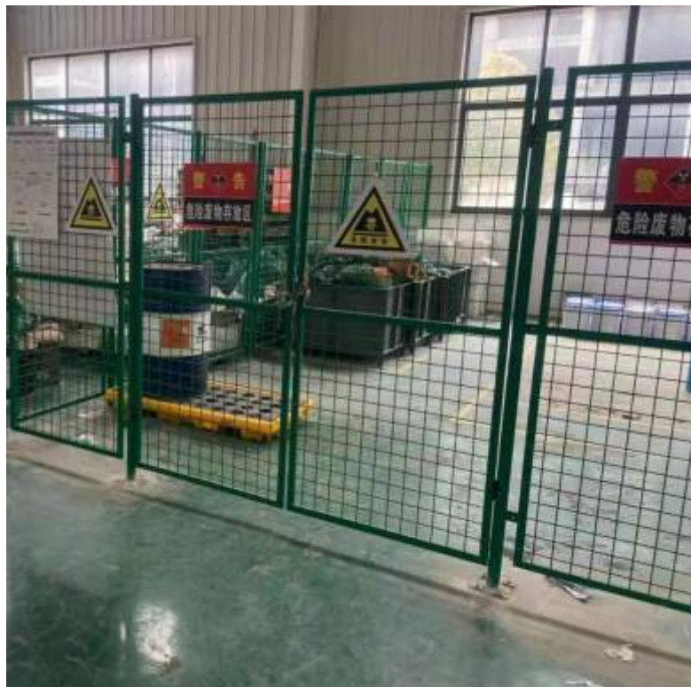
危废标识+环氧地坪+防渗漏托盘+周知卡
