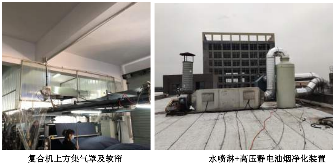
图 4-3 部分废气处理设施图
