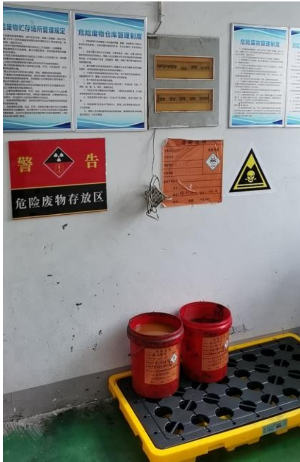
危废标识+环氧地坪+防渗漏托盘+危废管理制度
