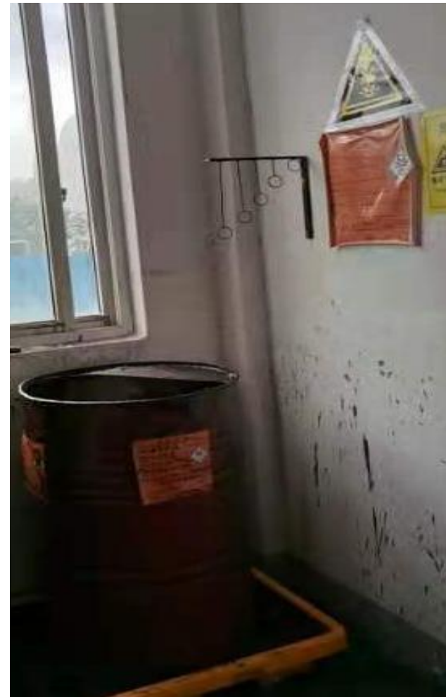
危废标识+环氧地坪+防渗漏托盘
