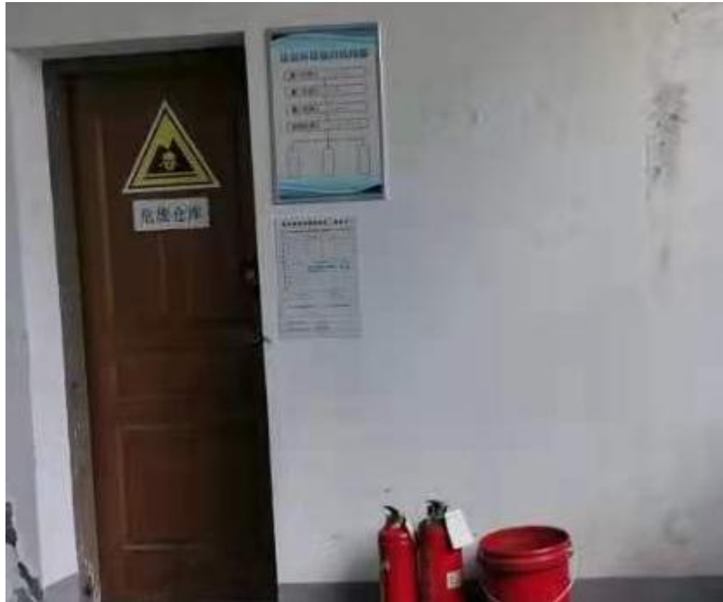
危废仓库标识+危废标识+周知卡+消防设施
