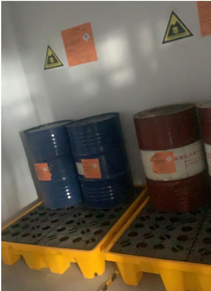
危废标识+防渗漏托盘+分类存放
