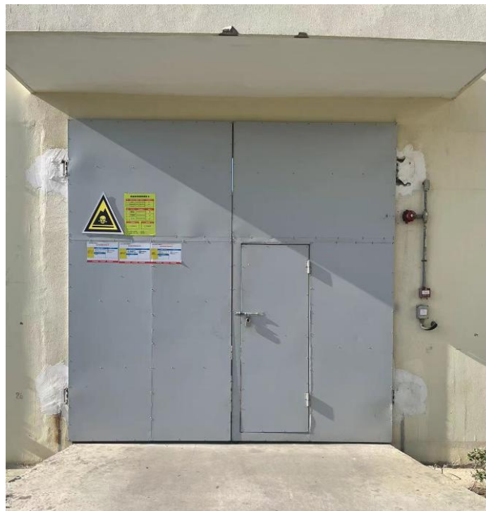
图 4-4 危废仓库建设情况
