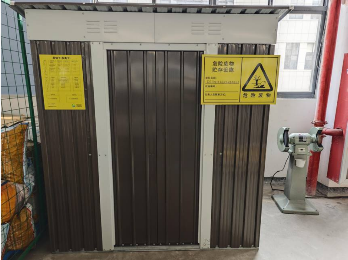
图 4-3 部分危废仓库设施图
